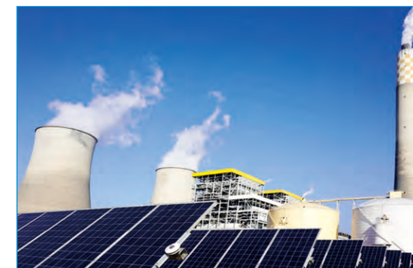
电力-送风机、一次风机、锅炉给水泵、凝结水泵、循环水泵等。
